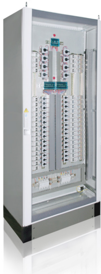
Рис. 7. Шкаф с автоматическими выключателями
