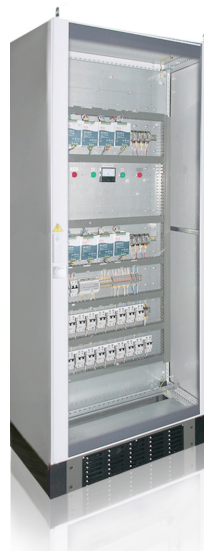
Рис. 8. Шкаф питания оперативной блокировки
